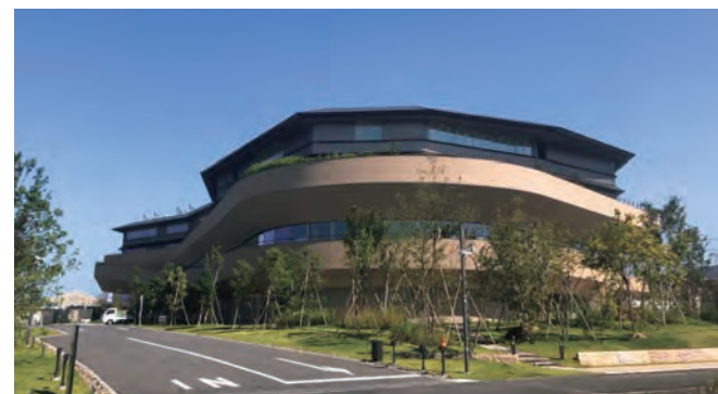
大和ハウスグループ新研修センター建設プロジェクト
