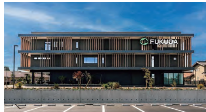
株式会社フクダ新社屋建設工事
