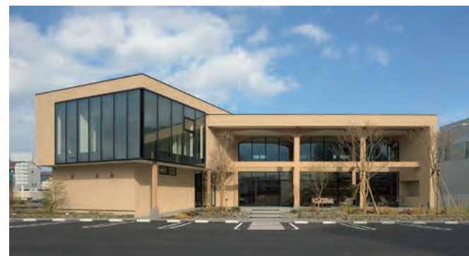
TOAHOME 株式会社新社屋新築工事
