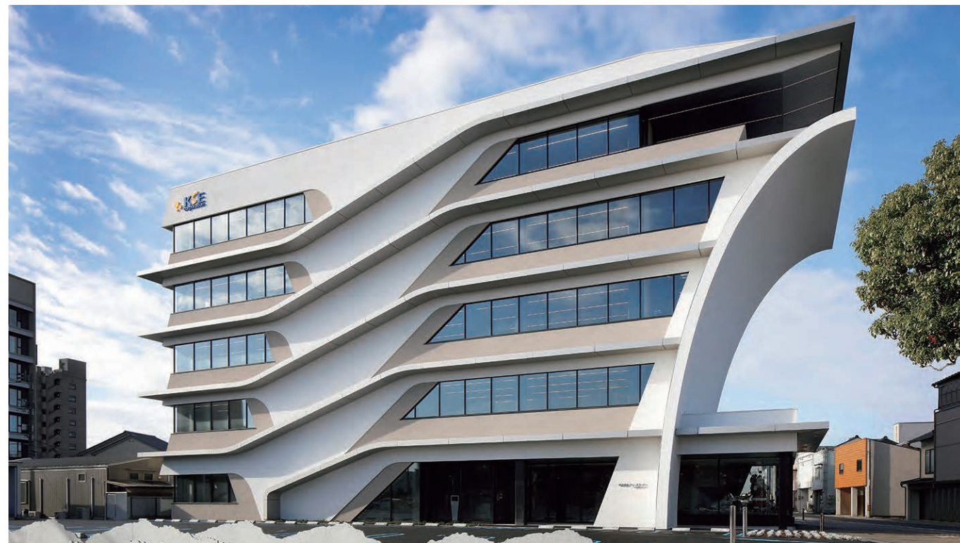
株式会社ケー・エス・イー新築工事
